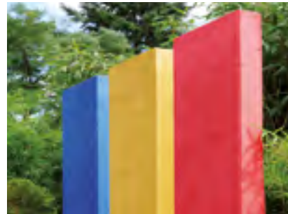
Sichtbeton Grau bauseits gespachtelt und gestrichen
