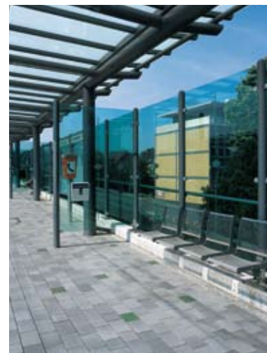
Nach der Reinigung: Fläche wie neu.
