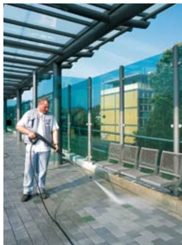
Reiniger aufsprühen. Fläche abspritzen.
