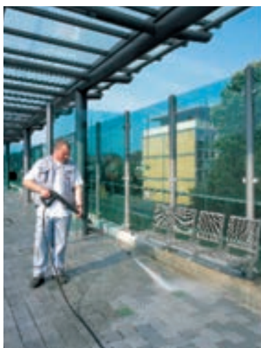
Reiniger aufspritzen. Fläche abspritzen.
