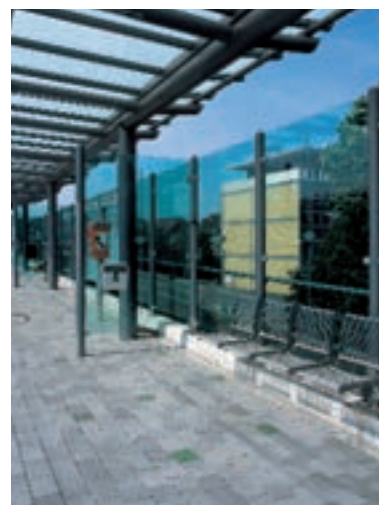
Nach der Reinigung: Fläche wie neu.
